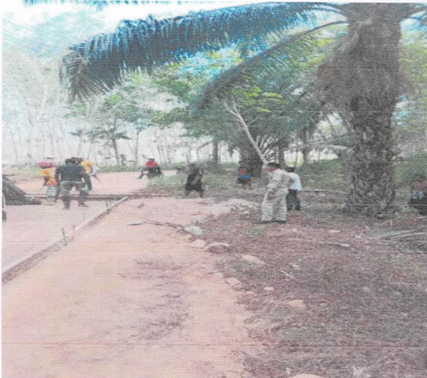
โครงการก่อสร้างถนนแอสฟัลต์ติกคอนกรีตสายช่องพระจันทร์ หมู่ที่ ๗
