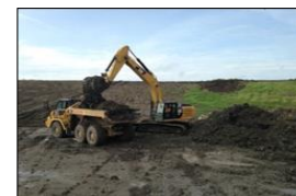
ใช้แบคโฮตักดินตะกอนขึ้นแท้งแล้วขึ้นรถ/เรือ บรรทุก
