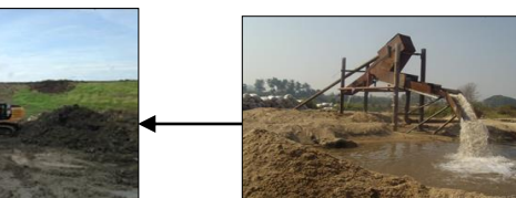
ใช้แบคโฮตักดินตะกอนขึ้นแท้งแล้วขึ้นรถ/เรือ บรรทุก
